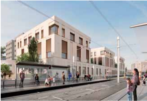
① CHU de Bordeaux (33) Bâtiment pédiatrique Pellegrin
