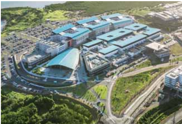
③ CHT de la Nouvelle Calédonie / Nouméa (98) Médipôle - Les urgences et l'hélistation
